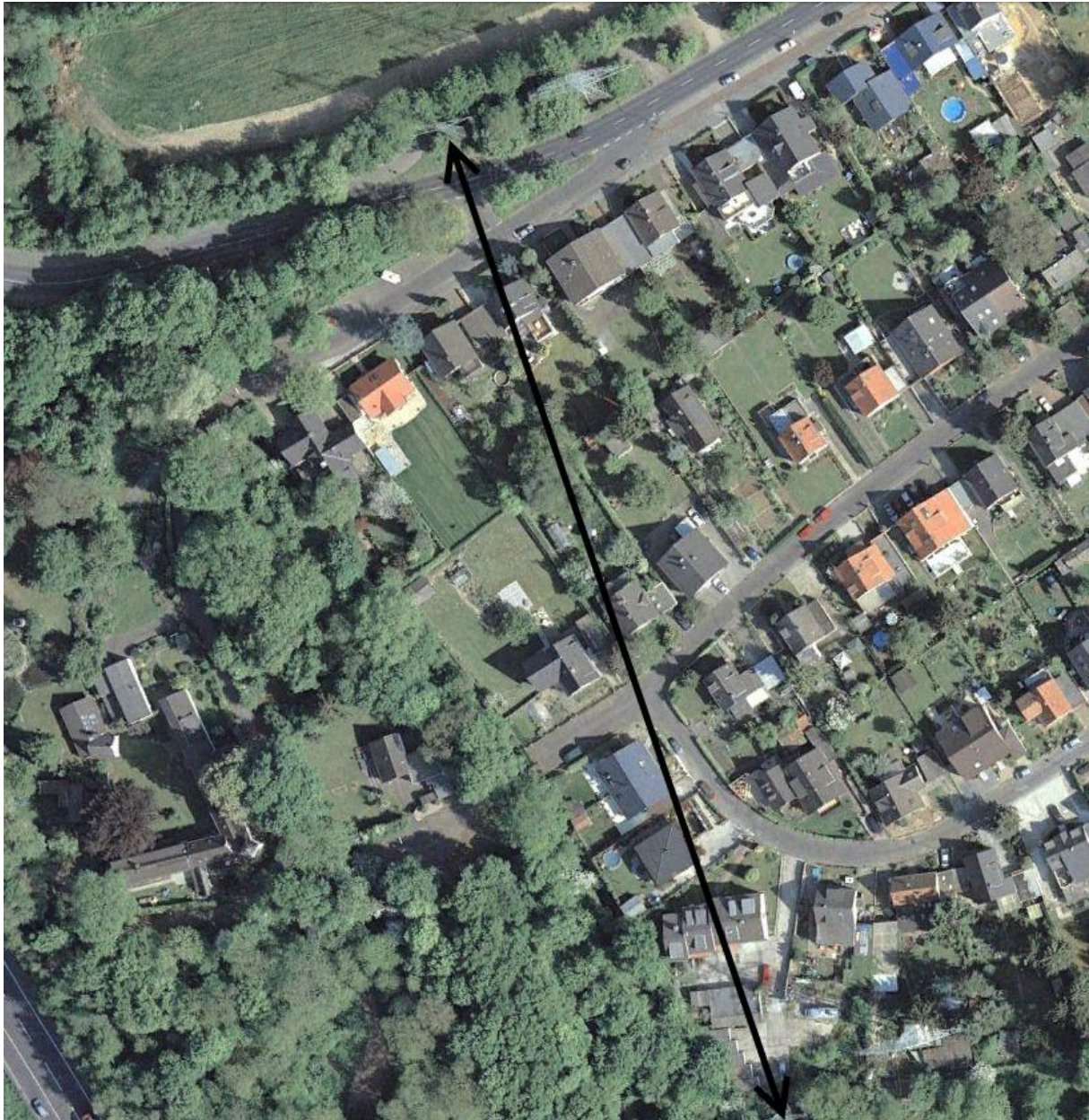
Abbildung 6: Unterbaute Bahnstromleitung im Raum Köln
