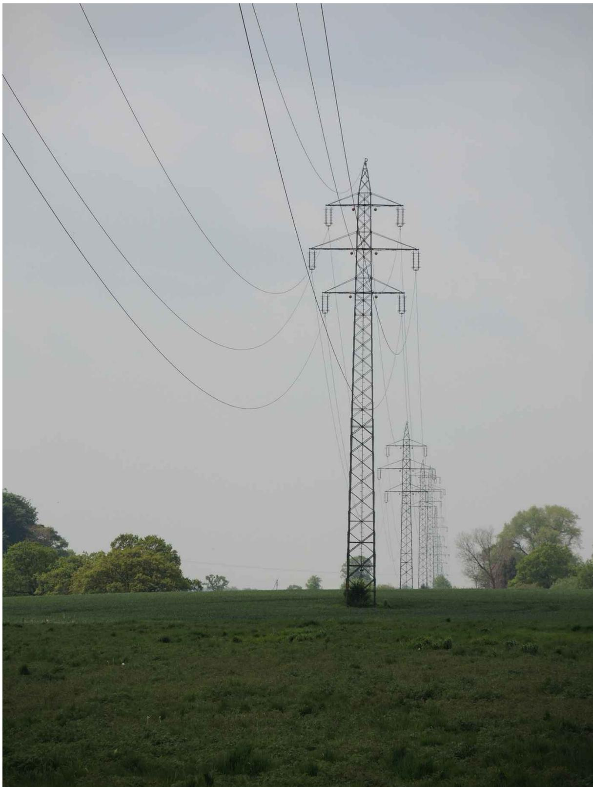
Mehr Ebenen – mehr Kollisionsmöglichkeiten: Eine solche Anordnung von Leitern in mehreren Ebenen müssen grundsätzlich vermieden werden und stellen aus Vogelschutzsicht neben der Erdseitmarkierung die verpflichtende Eingriffsminimierung dar.
