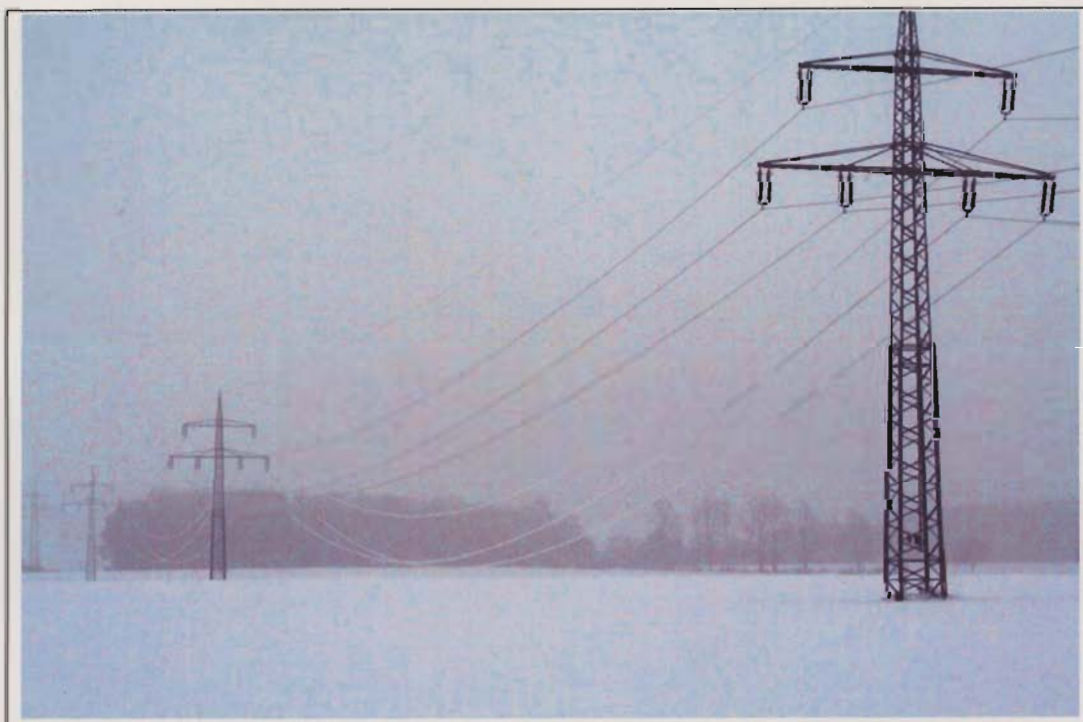
Bild 35: Freileitung 1503, Masten 82, 83 etc., Blick Richtung Süd. Bild RWE, 28.11.2005, 13:51 Uhr, nachbearbeitet.
