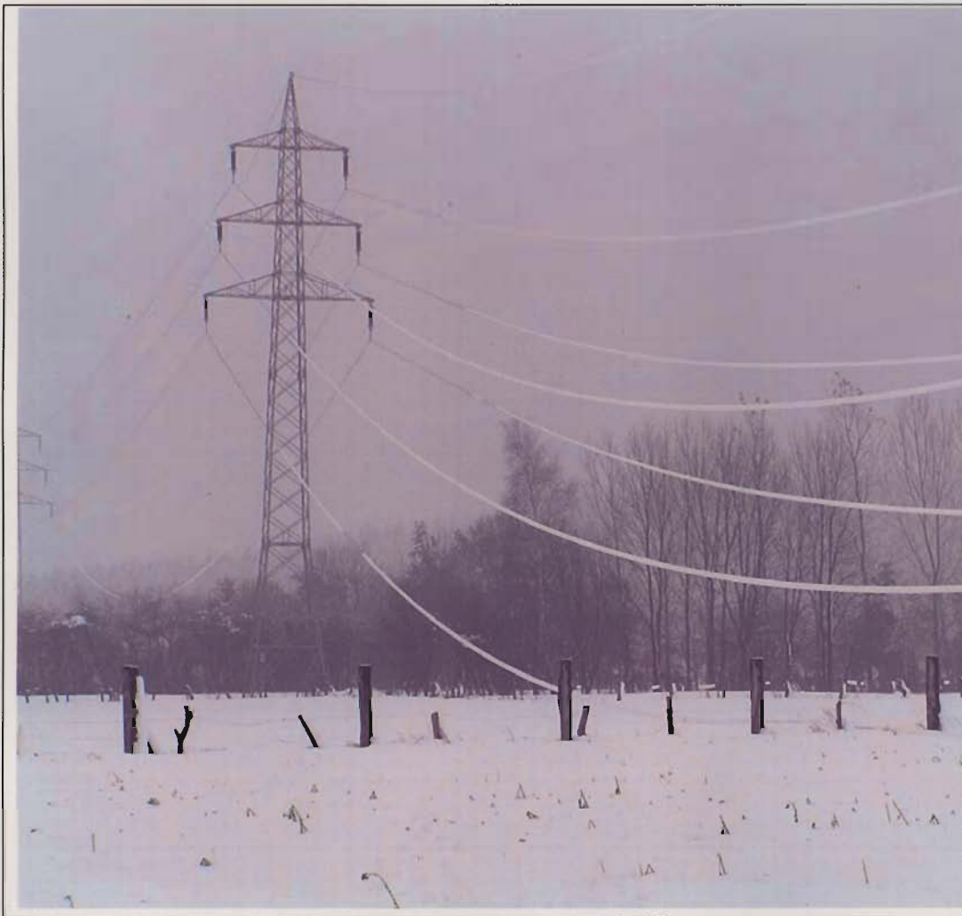
Bild 115: Schneewalzen auf allen Seilen, auch Erdseil, BL1525 Metelen-Roxel, südlich Leer zw. Mast 26 und 27, 26.11.2005, 15Uhr Foto Moog, [70]
