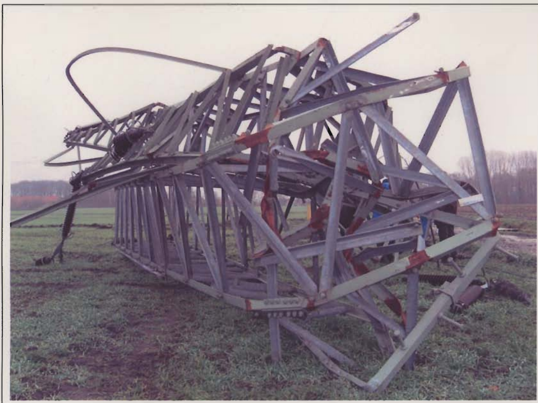
Bild 6: 1503Mast66, 2005-12-20, Dokumentation des Mastzustandes
