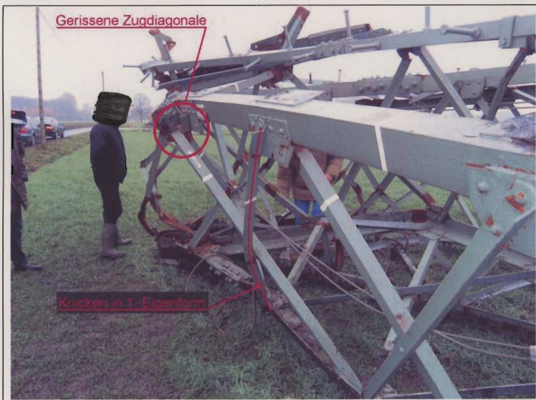
Bild 130 Stabilitätsversagen in der 1. Knickeigenform nach Versagen der Zugdiagonale
