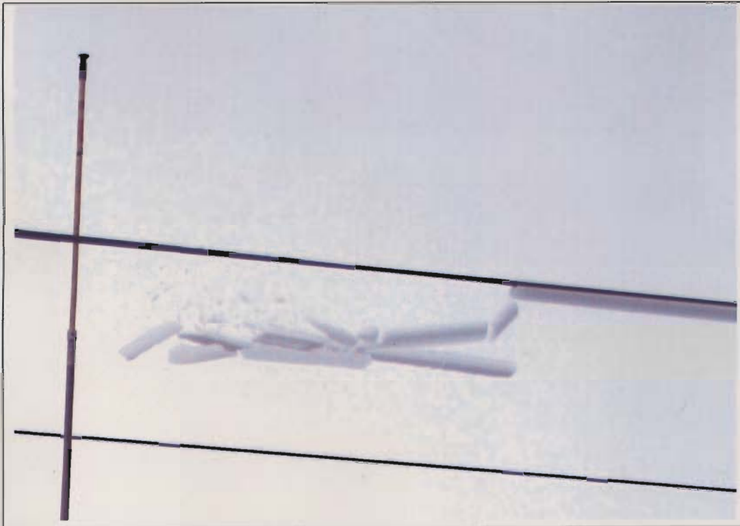
Bild 43: Freileitung 1503, zwischen den Masten M81 und M82, Ausschnitt aus dem vorigen Bild. Die Schneewalzen werden abgeschlagen und lösen sich stückweise.
