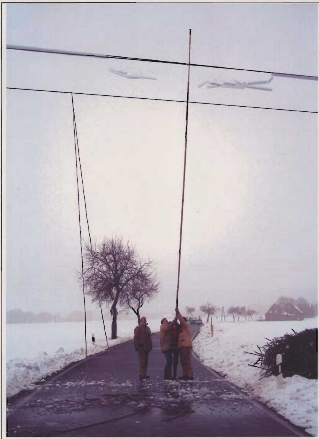
Bild 42: Freileitung 1503, zwischen den Masten M81 und M82, Blick Richtung Osten. Bild RWE, Aufnahme am 28.11.2005, 14:08 Uhr, nachbearbeitet. Die Schneewalzen werden abgeschlagen.
