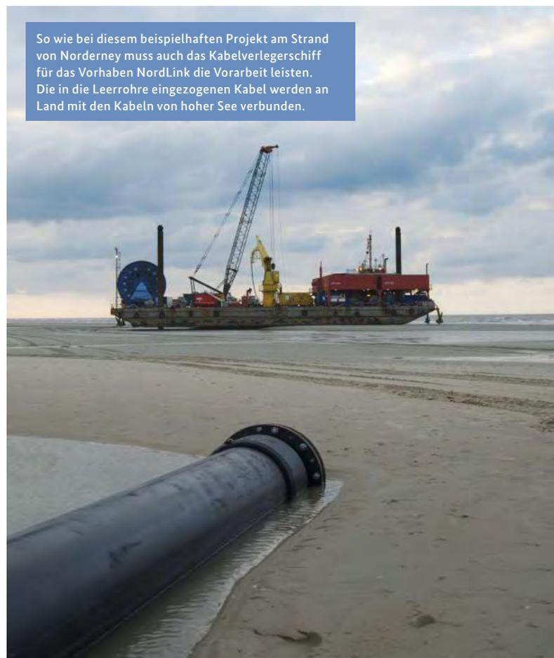
So wie bei diesem beispielhaften Projekt am Strand von Norderney muss auch das Kabelverlegerschiff für das Vorhaben NordLink die Vorarbeit leisten. Die in die Leerrohre eingezogenen Kabel werden an Land mit den Kabeln von hoher See verbunden.
